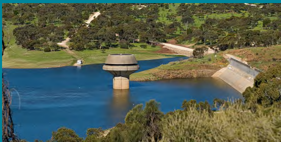
Little Para Reservoir. (Credit: SA Water.)
